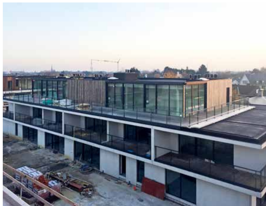
Deschacht leverde niet enkel alle pvc-materialen voor de buitenriolering, maar ook alle dakdichtingsmaterialen voor de platte daken en de verdichting op de ondergrondse parkeergarage.
